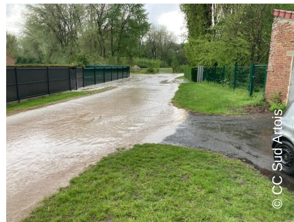
Coulées de boue Chérisy (62)
